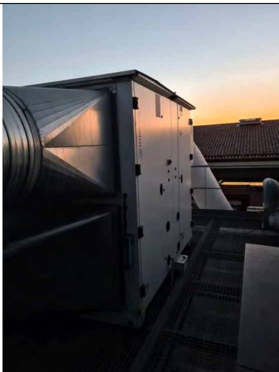
Autre centrale de traitement d'air
