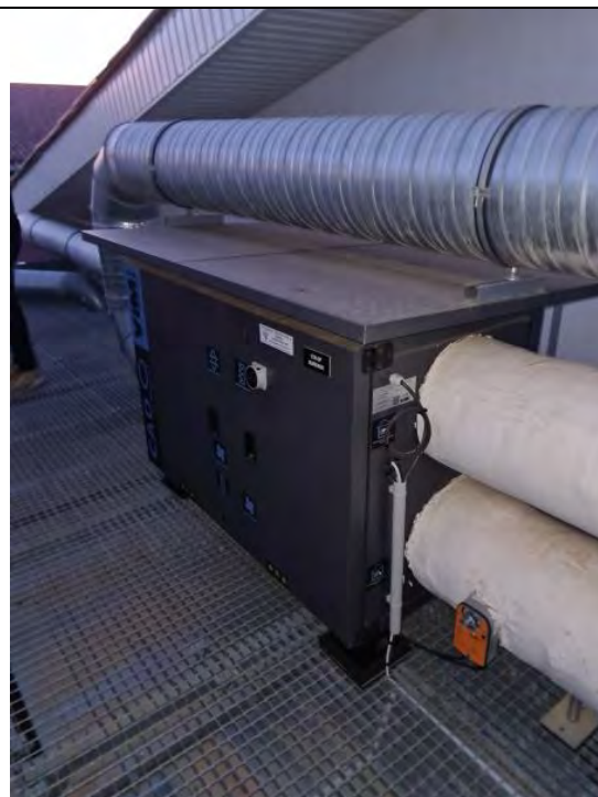
Centrale de traitement d'air
